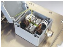
Klemmenkasten im Detail
